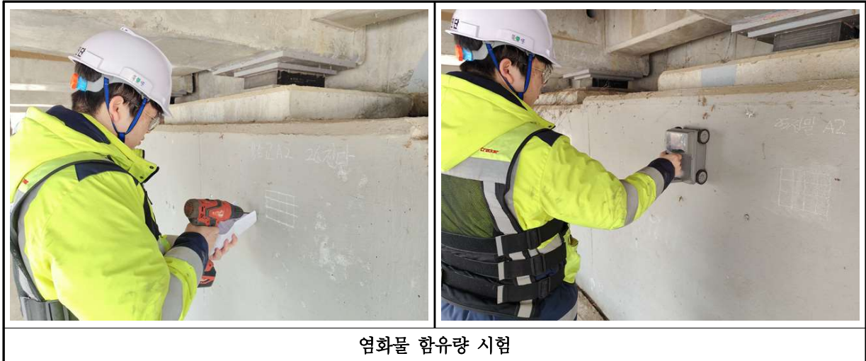
【사진 3.38】 염화물 함유량 시험 현장사진
