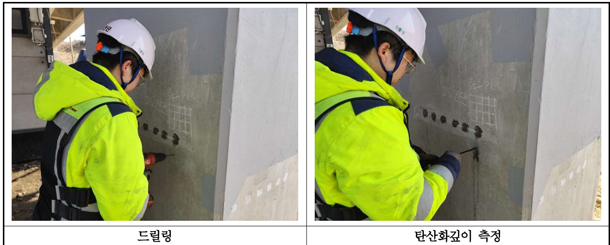
【사진 3.37】 탄산화 깊이 측정 현장사진
