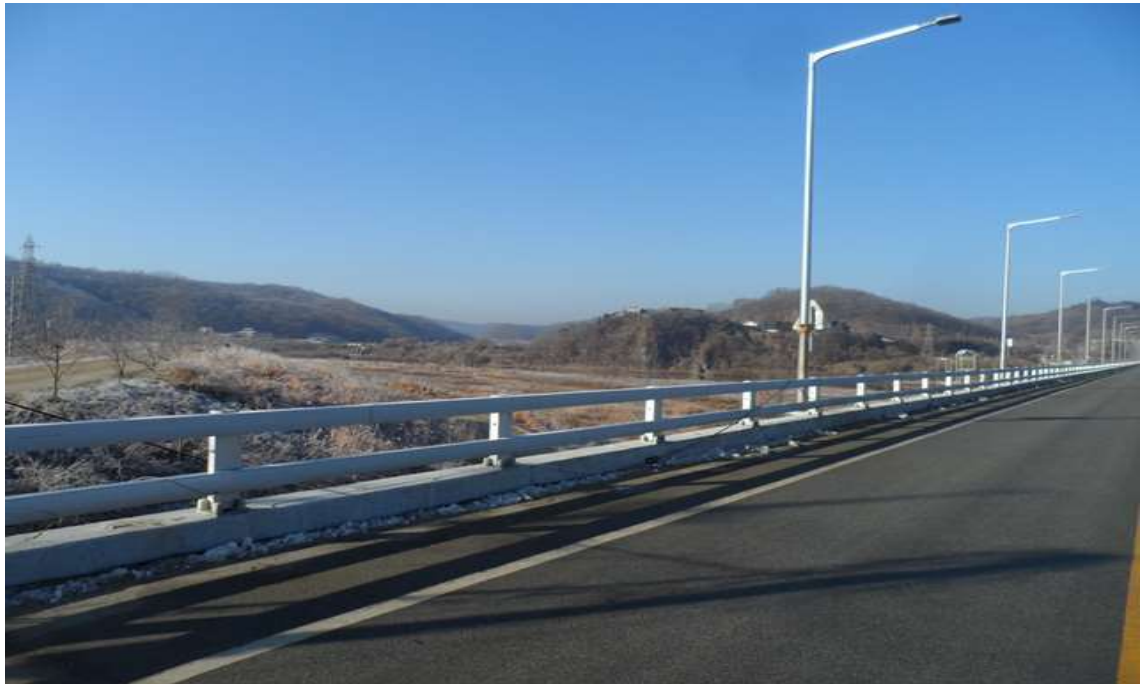
난간 및 연석 전경
