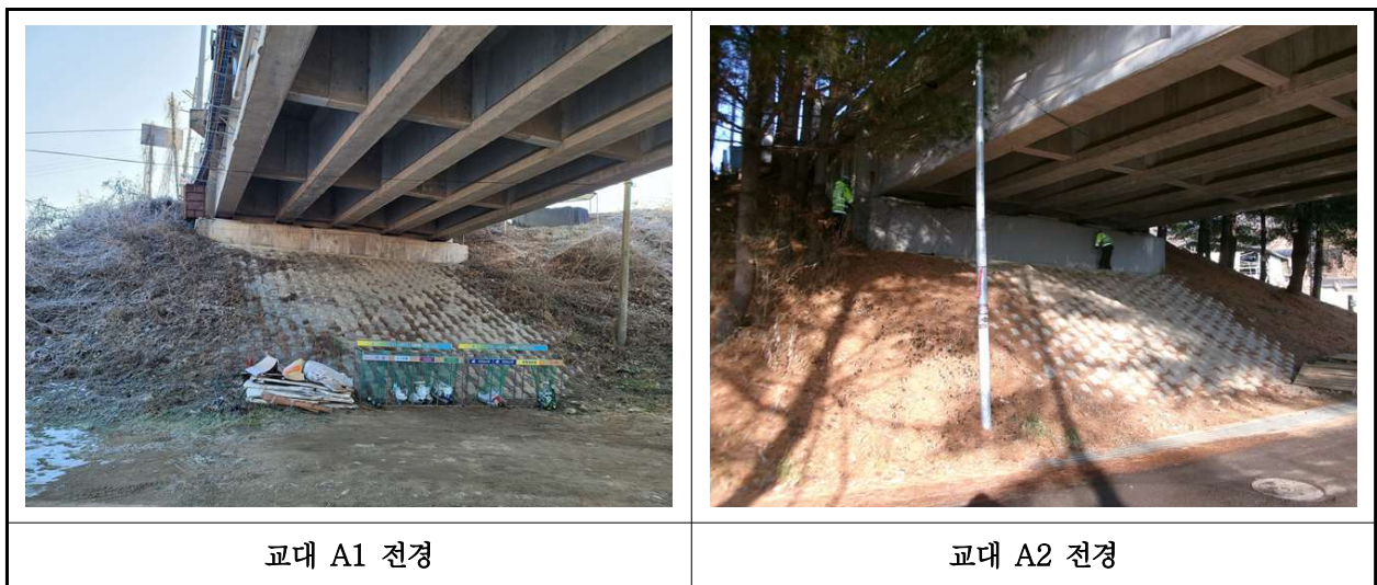
【사진 3.10】 교대 전경
