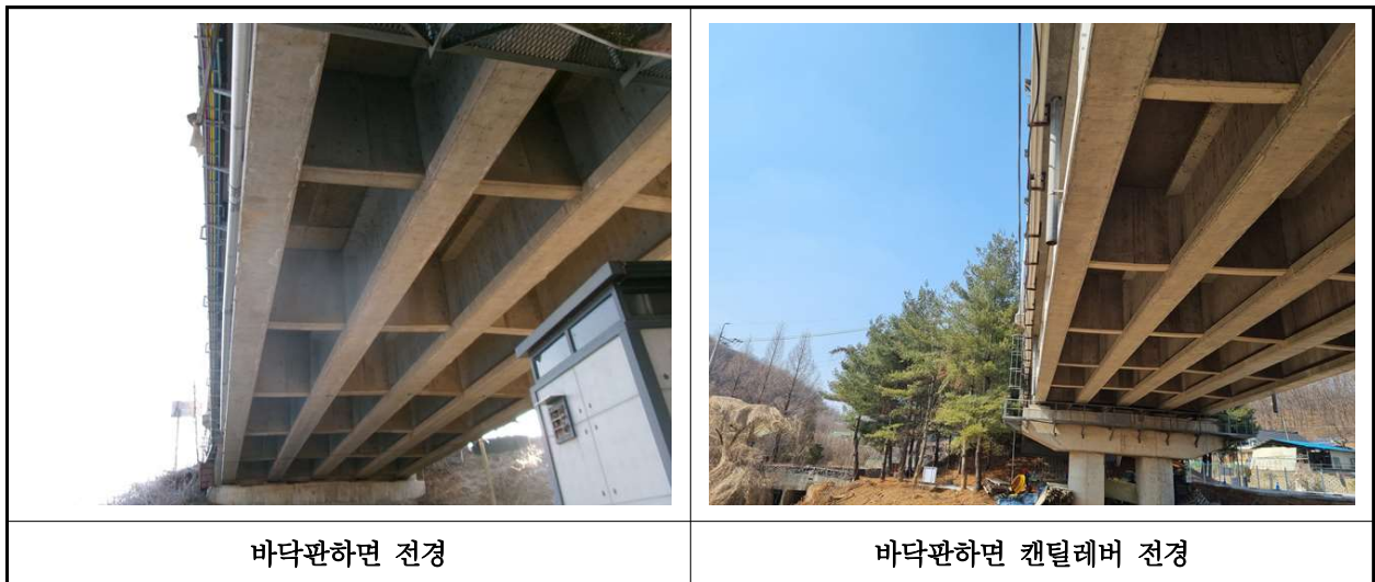
【사진 3.4】 바닥판하면 전경
