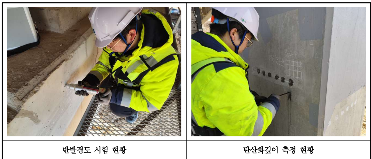
【사진 3.34】 콘크리트 내구성조사 현황
