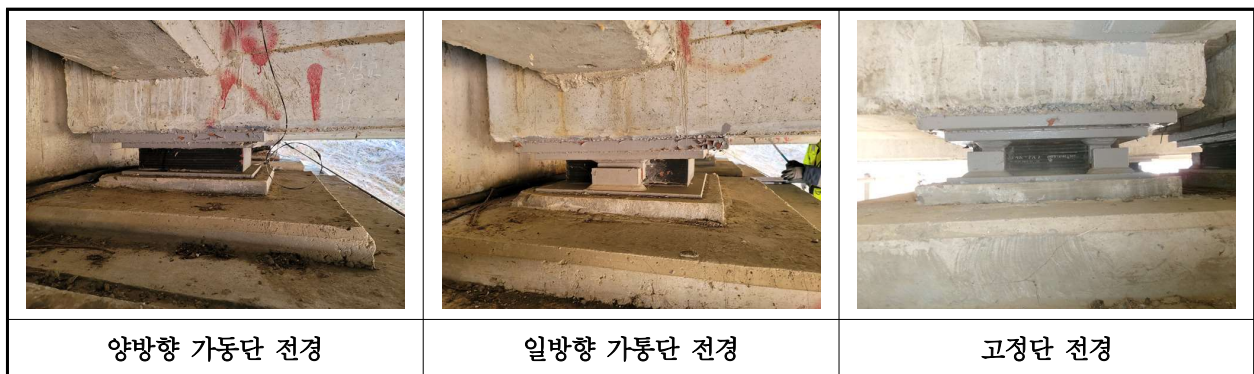
【사진 3.16】 교량받침 전경
