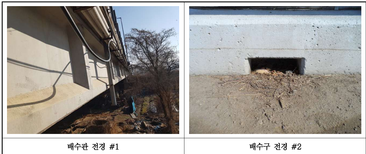
【사진 3.25】 배수시설 전경
