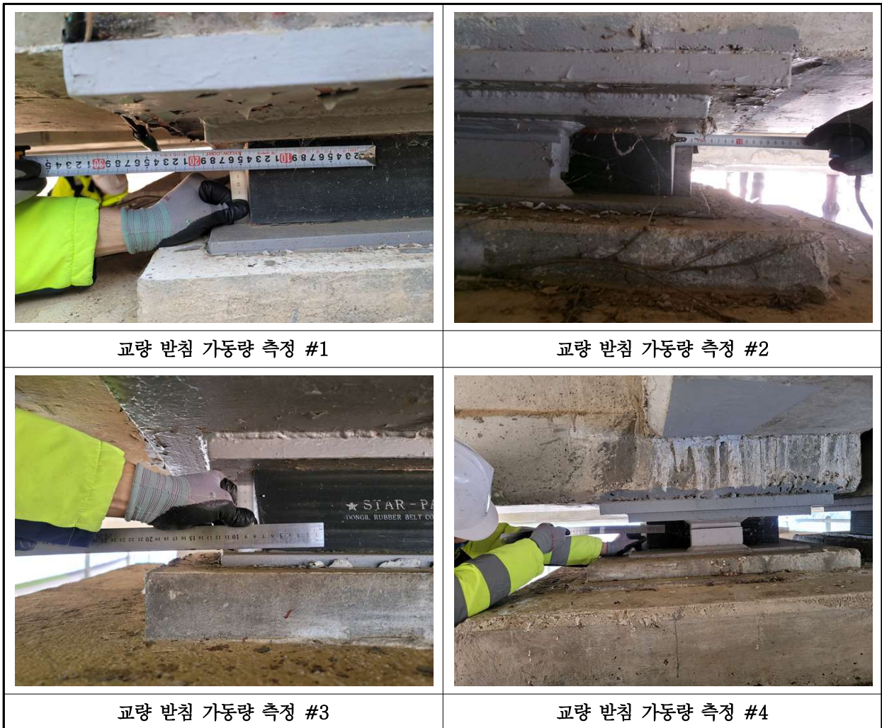
【사진 3.19】 교량받침 이동량 측정
