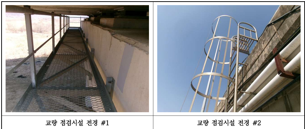
【사진 3.29】 교량 점검시설 전경
