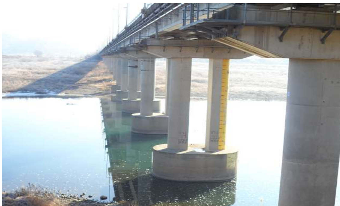
교각 P11~P16 전경
