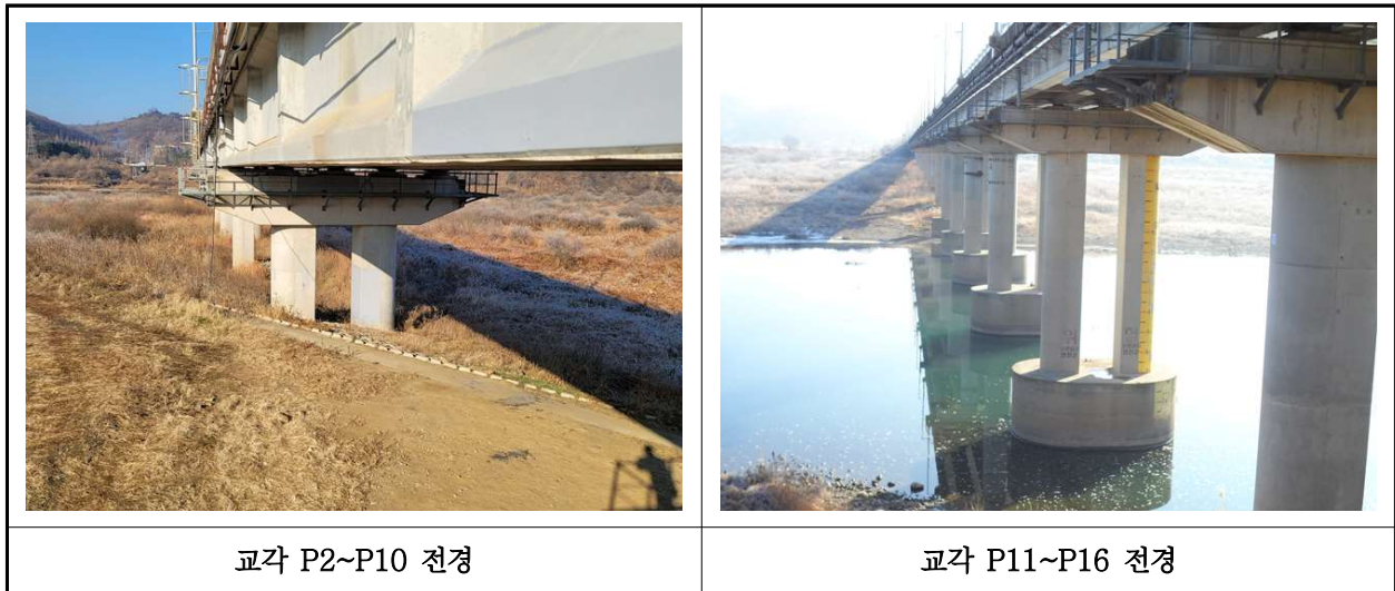
【사진 3.12】 교각 전경
