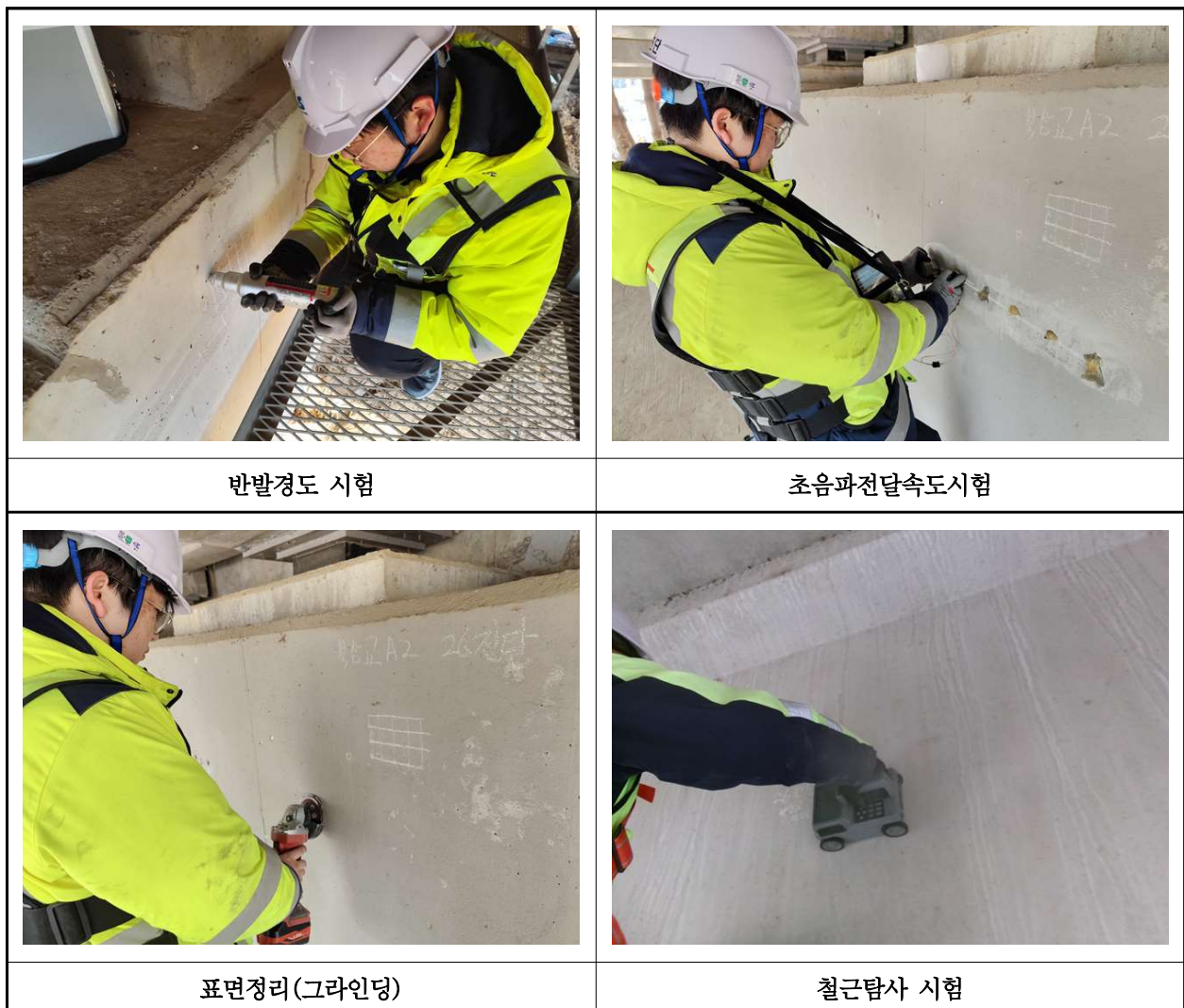
【사진 3.35】 콘크리트강도 시험 현장사진
