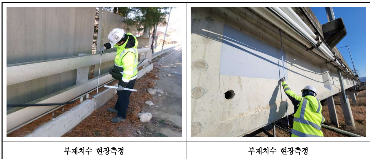
【사진 2.1】 부재 현장측정 전경
