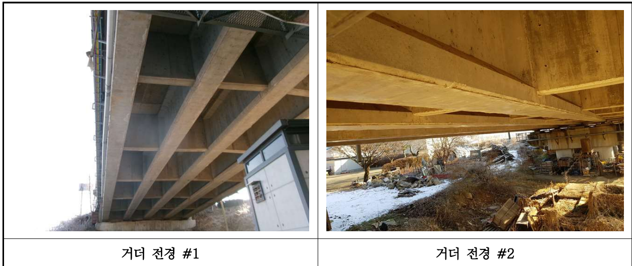
【사진 3.6】 거더 전경
