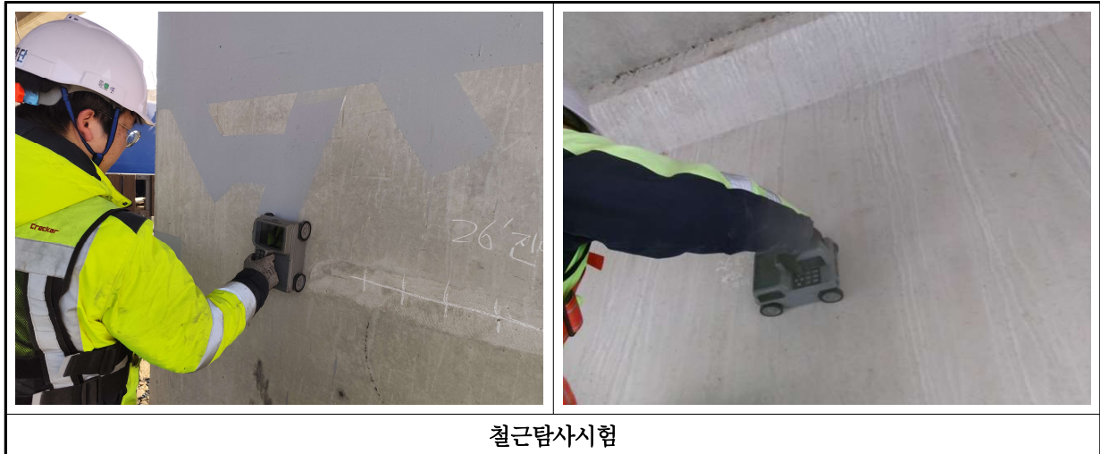
【사진 3.36】 철근탐사시험 현장사진
