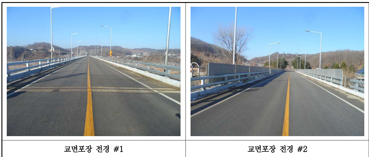
【사진 3.23】 교면포장 전경
