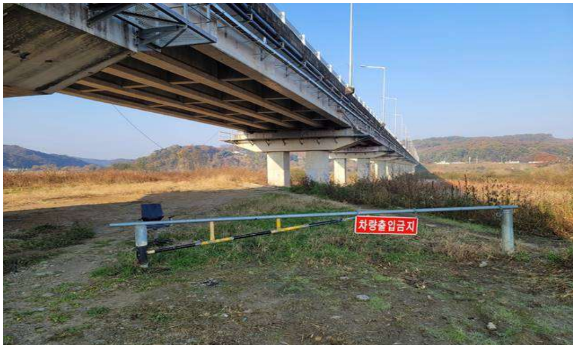
교각 P2~P10 전경
