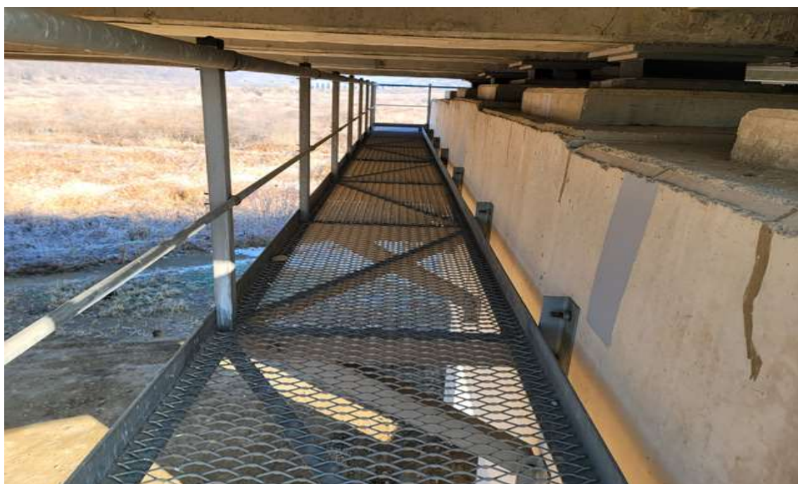
교량 점검시설 전경
