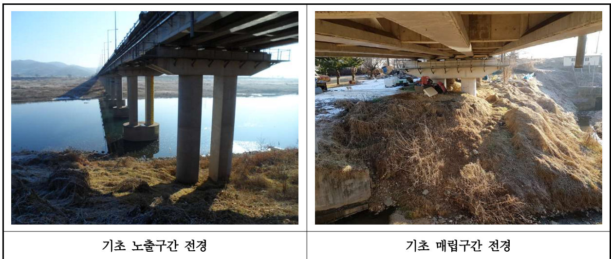
【사진 3.14】 기초 전경
